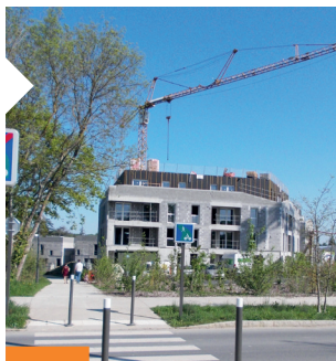
Liaison piétonne Vallon des Garettes - Orvault.
