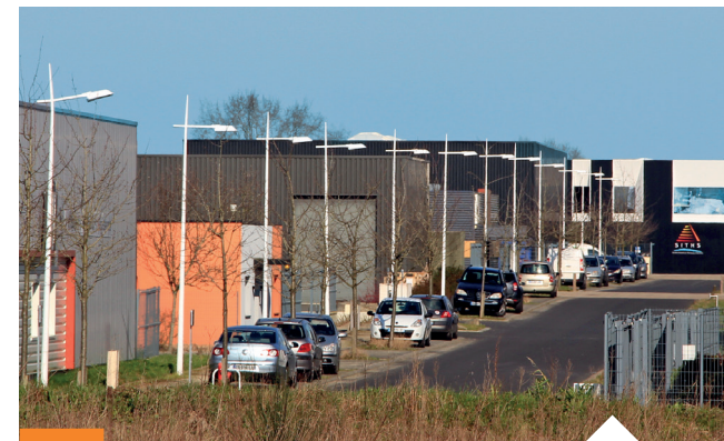
Parc d'activités Océane sud - Les Sorinières.
