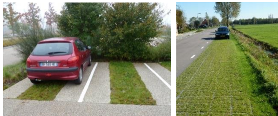
Bandes enherbées et stationnement avec système alvéolaire
