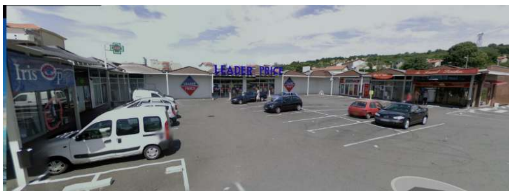
Exemple d'implantation de commerces autour d'un espace de stationnement mutualisé (Roche-la Molière- Loire)
