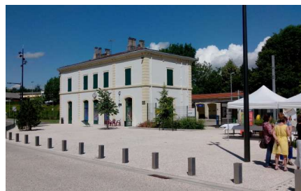
Aménagement du parvis de la gare de Vinay (38)
