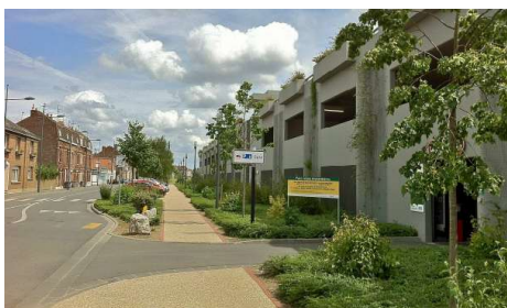
Aménagement d'un cheminement en direction de la gare d'Armentières (59)
