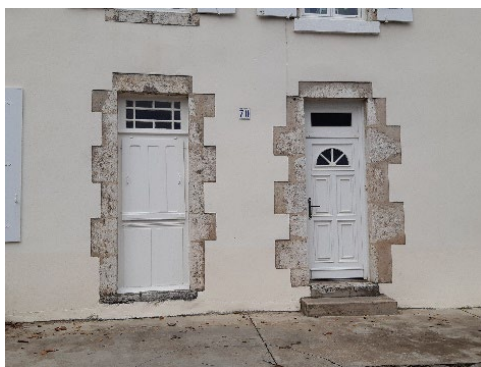
Exemples de menuiseries ne correspondant pas à l'époque et à l'architecture de la construction
