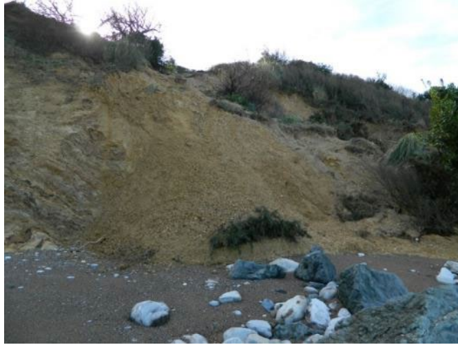
Illustration 36 - Glissement de terrain affectant le sentier du littoral à Erromardie (© Observatoire de la Côte Aquitaine, 17/02/2014)
