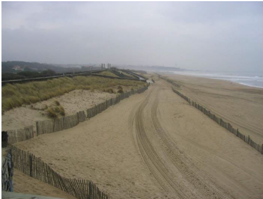
Illustration 33 - Plage sableuse d'Anglet (©OCA, 2008) et aménagement piétonnier du cordon dunaire. La gestion hivernale de la plage s'effectue par l'installation de ganivelles pour stocker le sable au niveau de l'interface dune/plage sur le cordon dunaire résiduel.
