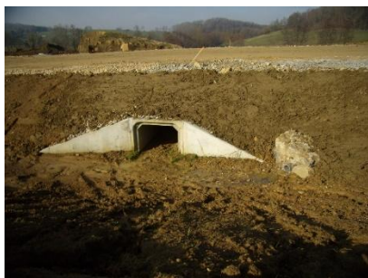
Exemple d'un ouvrage de franchissement pour la faune à Lons-le-Saunier (source : Jura Nature Environnement)
