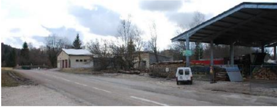
Photo 1 : vues de la zone d'activités de la Mouille depuis la route D69
