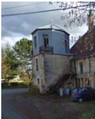
ELEMENT BATI N°2 : Toiture et pignon en bardage métallique: 16 rue du Pont / rue du Stade
