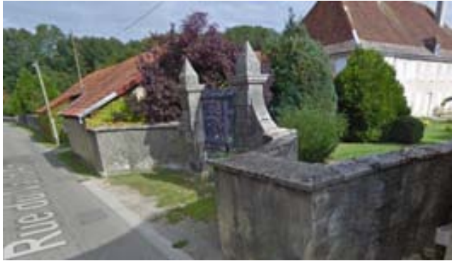
ELEMENT BATI N°1 : Piliers d'entrée et mur en pierre propriété bourgeoise : 20 rue du Val d'Amour
