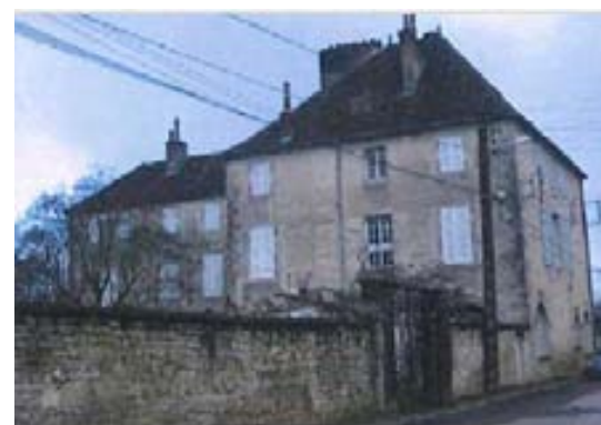
ELEMENT BATI N°19 : Demeure façade sud : rue du bas de la Fin/quartier du Port
