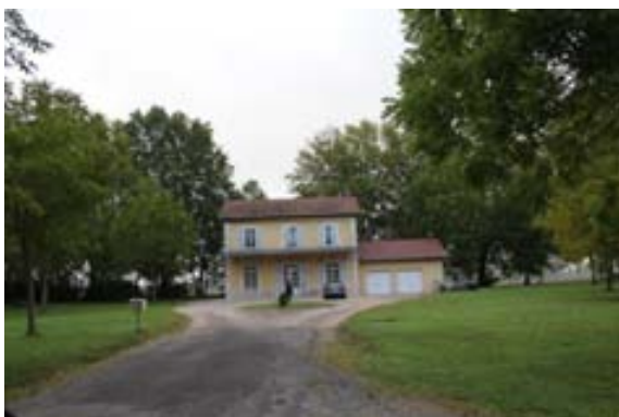
ELEMENT BATI N°1 : Ancienne halte de gare : rue de la Gare
