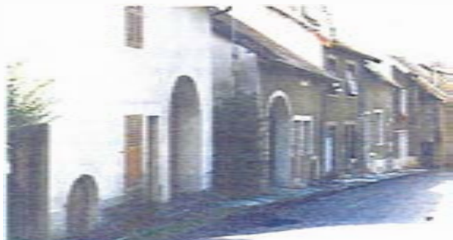
MESNAY : un alignement de maisons vigneronnes de type rural.
