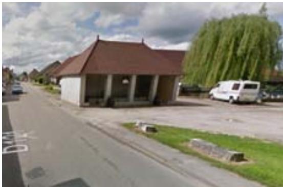
ELEMENT BATI N°8 : Lavoir : rue du Bois
