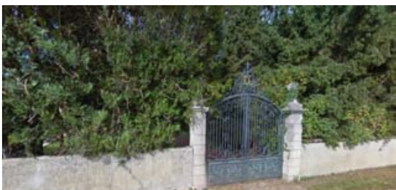
LINEAIRE A : Piliers de portail et muret en traversée de village : 10 Rue du Val d'Amour
