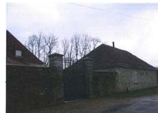
ELEMENT BATI N°9 : Demeure et mur d'enceinte, portail et dépendance : rue du Lavoir LINEAIRE B : Mur d'enceinte en pierre et portail : rue du Lavoir
