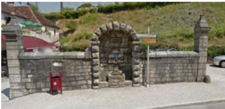
ELEMENT BATI N°3 : Fontaine : 21 rue de la République
