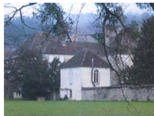
ELEMENT BATI N°18 : Façade Sud, pavillon : rue du bas de la Fin
