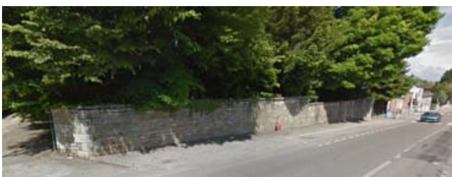
LINEAIRE A : Mur pierre : parc château rue Léon Guignard (RD472)
