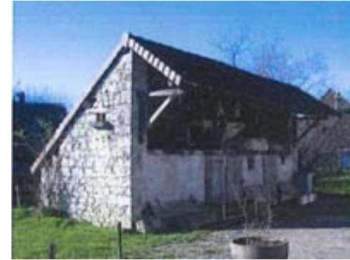
ELEMENT BATI N°17 : Soue à cochon et pigeonnier : rue du Fossé
