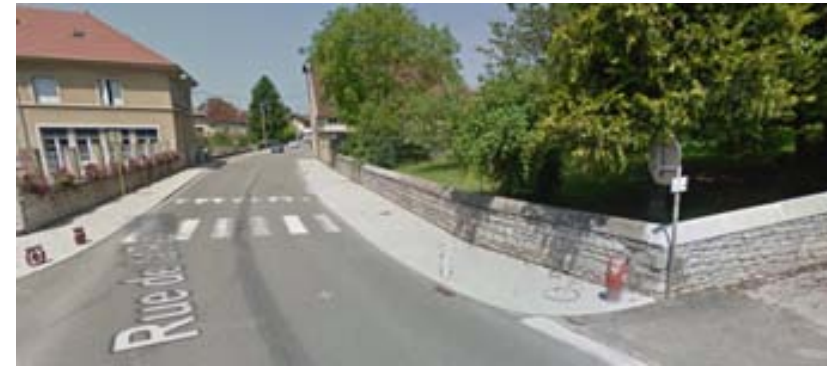
LINEAIRE A : Mur pierre : face à l'école maternelle : rue de la République
