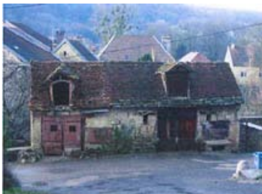
ELEMENT BATI N°15 : Ancienne sous à cochons : rue du Coin du Four
