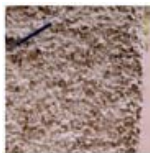
Exemple d'enduit brut de projection dit rustique Mise en œuvre jetée ou broyée
