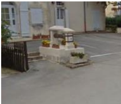
ELEMENT BATI N°2 : Puits en pierre : rue du val d'Amour/face à l'Eglise
