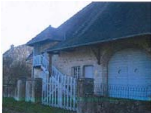
ELEMENT BATI N°16 : Montée d'escaliers en bois et détail de toiture : rue des Andrées
