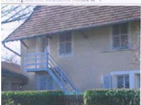
ELEMENT BATI N°15 : Montée d'escalier en bois : rue des Fossés du Sud
