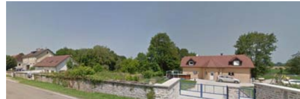
LINEAIRE D : Mur en pierre en bordure de route : rue Louis Pasteur
