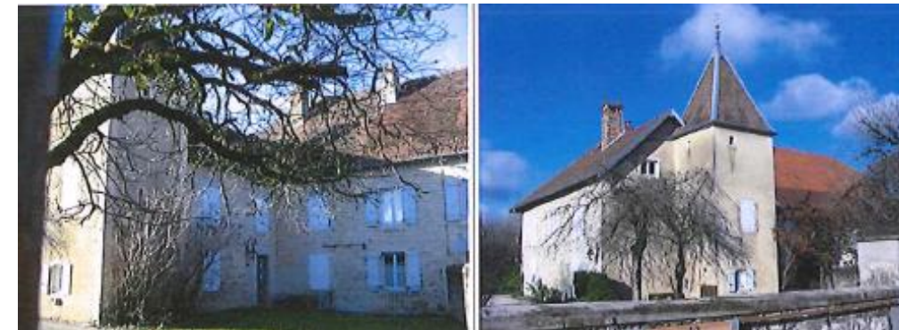
ELEMENT BATI N°5 : Demeure, parc, mur d'enceinte : Grande Rue
