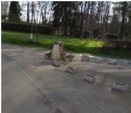
ELEMENT BATI N°2 : Abreuvoir : 5 rue du Chalet
