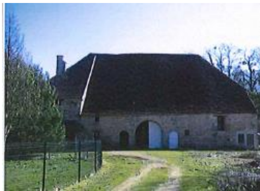
ELEMENT BATI N°3 : Dépendance en brique (château) : rue du Dessus
