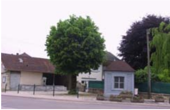
ELEMENT BATI N°8 : Bascule et maisonnette : Intersection rue du Lavoir/rue Edgard Faure
