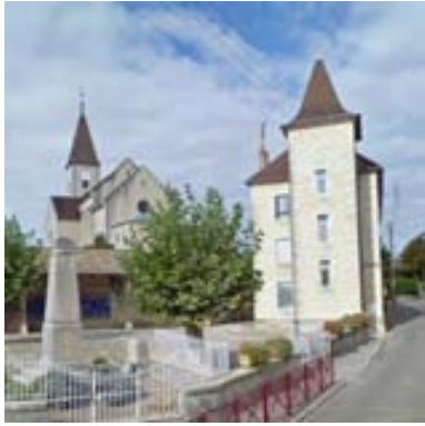
ELEMENT BATI N°1 : Mairie : façade, toiture : rue du Val d'Amour, 1
