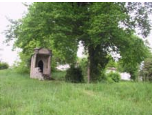
ELEMENT BATI N°31 : Chapelle : chemin de Bauquet
