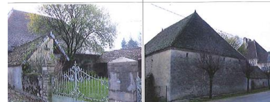
ELEMENT BATI N°4 : Demeure avec parc : 67 rue du Val d'Amour
