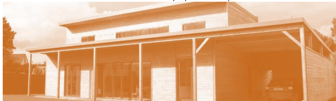
Exemple d'un étage construit en attique, Chantepie (35)
