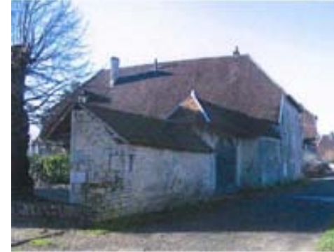
ELEMENT BATI N°10 : Portail et ferme : rue de l'Eglise
