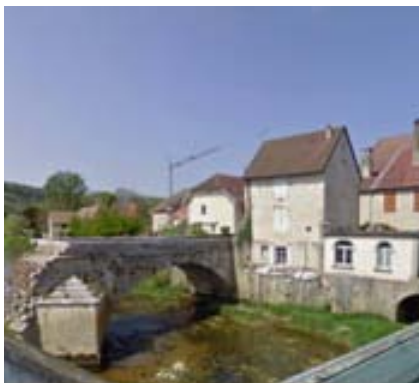
ELEMENT BATI N°12 : Arche de l'ancien pont en pierre : rue du Port
