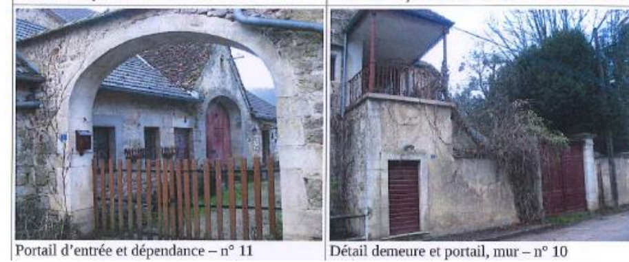
ELEMENT BATI N°24 : Portail d'entrée et dépendance, détail demeure et portail, mur : rue du bas de la Fin/quartier du Port
