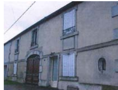
ELEMENT BATI N°28 : Modénature de façade à conserver : rue du Lavoir
