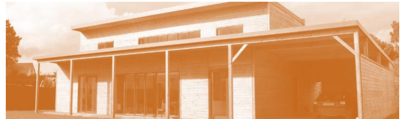
Exemple d'un étage construit en attique, Chantepie (35)
