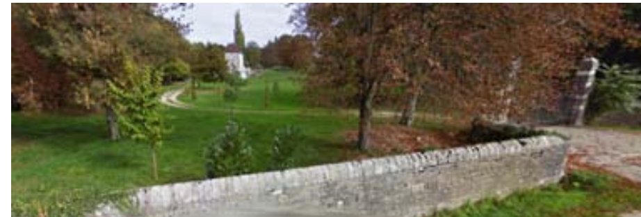
CONE DE VUE N°2 : Conserver la vue sur le château en proscrivant toute construction entre les deux pavillons, 20 mètres de part et d'autre de l'entrée sud jusqu'à la façade du château
