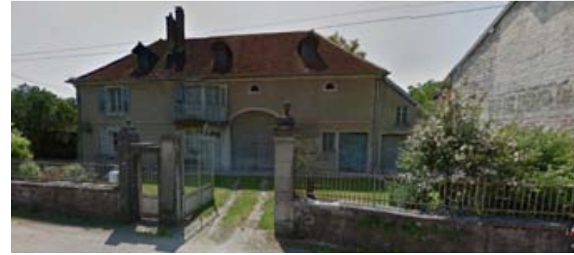
ELEMENT BATI N°5 : Demeure, 16 Grande Rue LINEAIRE B : Piliers, mur et portail, 16 Grande Rue
