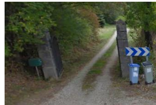
ELEMENT BATI N°4 : Piliers d'entrée du parc du château d'Augerans : rue du Val d'Amour
