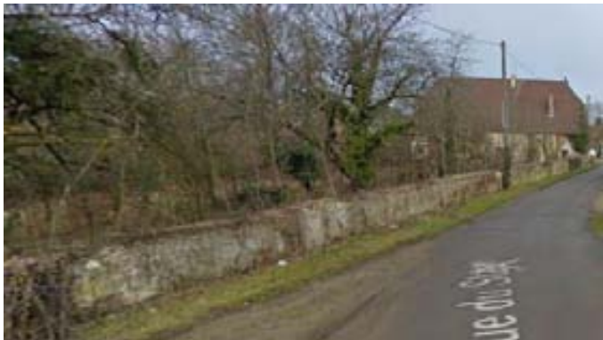
LINEAIRE A : muret pierre : 16 rue du Pont / rue du Stade
