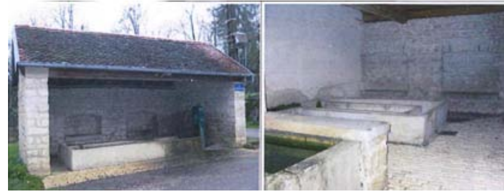
ELEMENT BATI N°10 : Fontaine/Lavoir : rue du Château d'Eau
