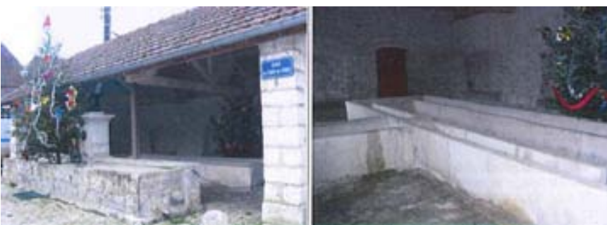
ELEMENT BATI N°30 Fontaine/Lavoir, rue du Coin du Four
