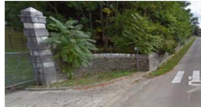
LINEAIRE B : Mur d'enceinte, portail et parc du château d'Augerans : rue du Val d'Amour
