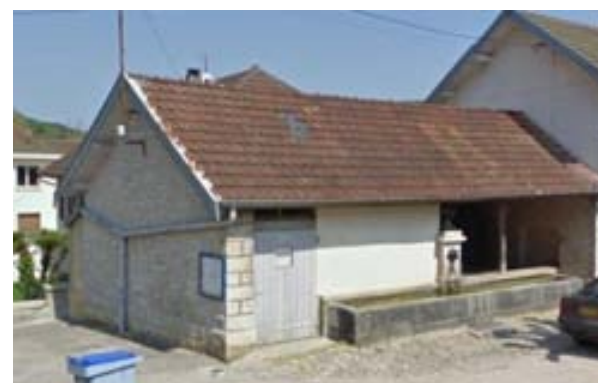
ELEMENT BATI N°6 : Fontaine et lavoir : Intersection rue du Lavoir/rue Edgard Faure
