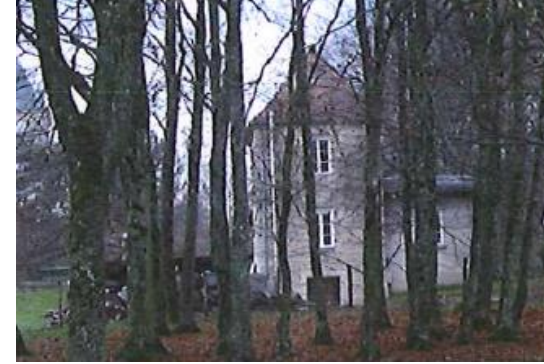
ELEMENT BATI N°2 et 3 : Un des deux pavillons à l'entrée principale d'origine du château d'Augerans
