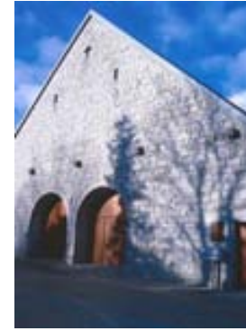
ELEMENT BATI N°3 : Ancienne grange liée à une congrégation religieuse : rue du Pavé
