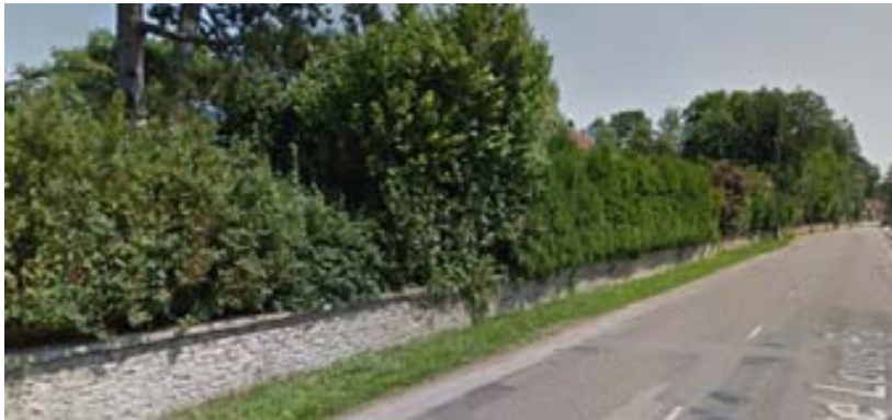
LINEAIRE A : Mur pierre propriété : 15 au 19 rue Louis Pasteur
