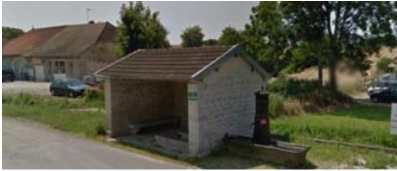
ELEMENT BATI N°1 : Fontaine et lavoir : rue du Lavoir
