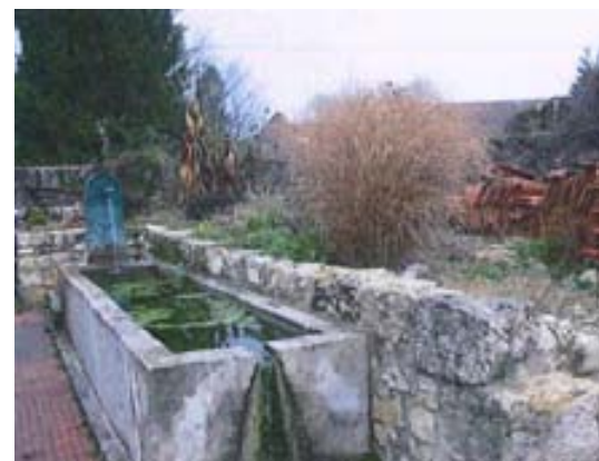
ELEMENT BATI N°5 : Fontaine : rue du Dessus
