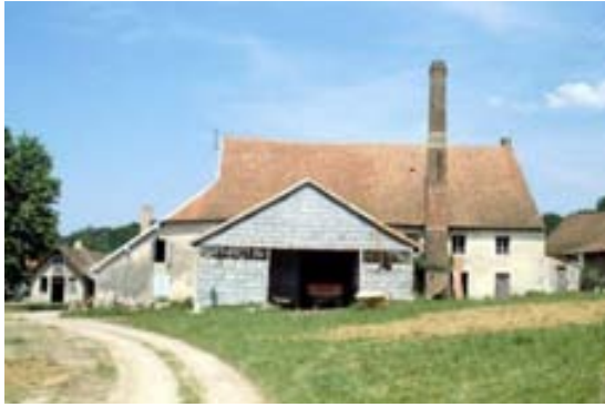
ELEMENT BATI N°1 : Usine de flaconnage dite verrerie de la Vieille Loye : chemin de la verrerie
