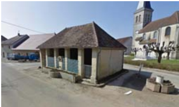
ELEMENT BATI N°2 : Lavoir couvert : place de l'Eglise
