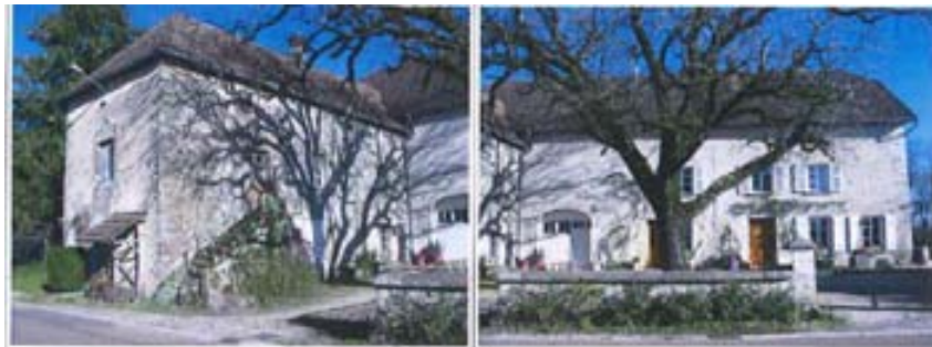
Bâtiment en retour d'équerre Demeure, arbre remarquable et parc à l'arrière ELEMENT BATI N°13 : Bâtiment et demeure : rue de la Rivière
