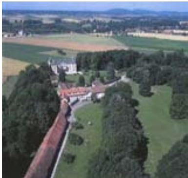
ELEMENT BATI N°2 : Ensemble bâti, dépendances du Château de Clairvans
