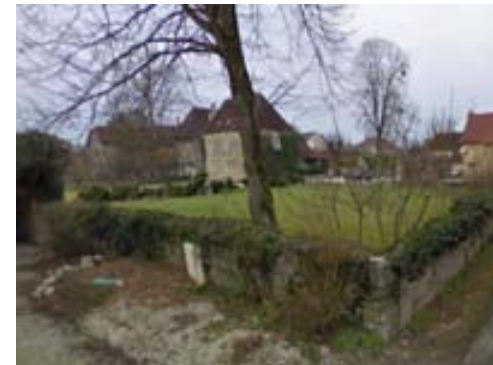
LINEAIRE A : Muret pierre : 56 Grande rue
