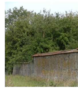
Mur en pisé – Eydoche
