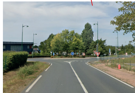
Photo de la RD943 : entrée de ville est de La Châtre. Activités commerciales des deux côtés de la chaussée.
