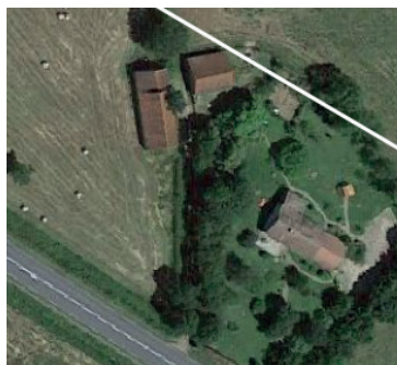
Exemple d'habitations existantes concernées par la bande des 75m : RD 927, Sarzay
