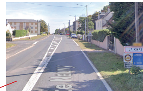
Photo de l'entrée Ouest de la Châtre par laquelle arrive la départementale 927
