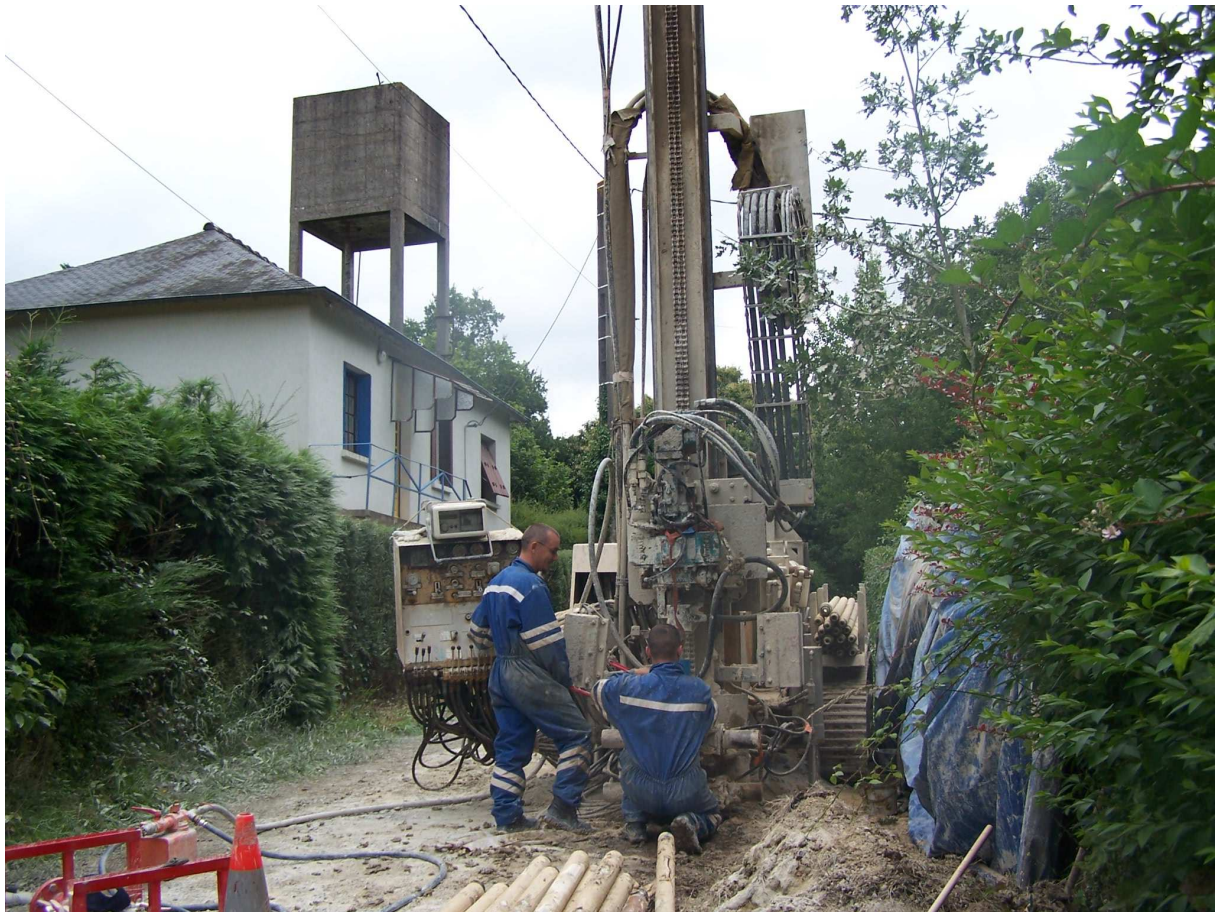
Figure 5 : Photographie de la foreuse en cours de préparation d'un sondage rue de la Mine (Site 1 – concession la Touche)
