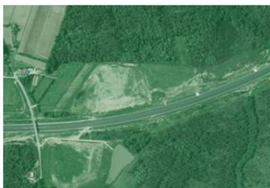
Photographie du terrain avant la fin des travaux sur la section (27 Mai 2001)
