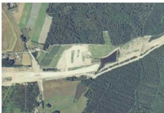
Photographie du terrain après le début des travaux (25 Juillet 1999)
