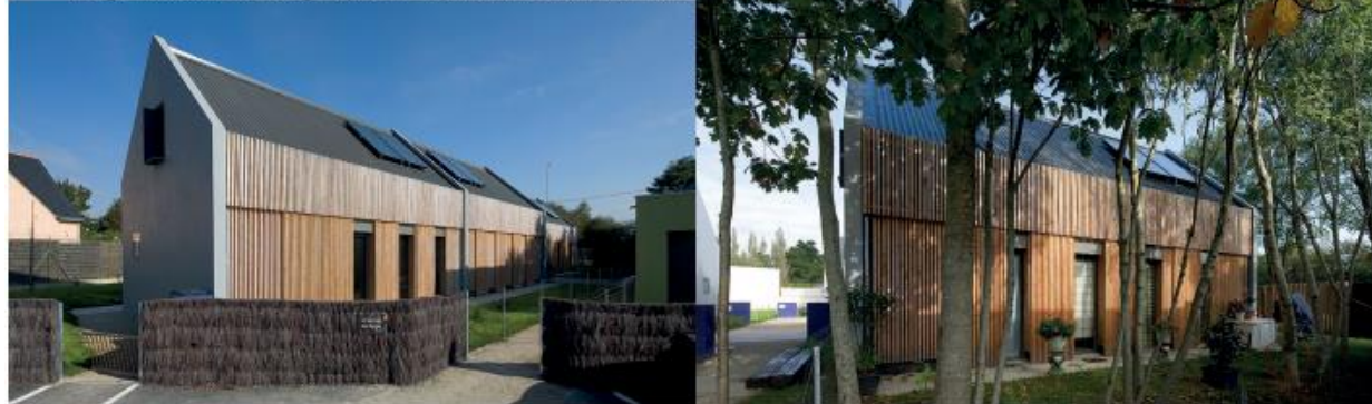
TREILLÈRES (44) 9 logements individuels groupés - Jacques Boucheton Architecte
