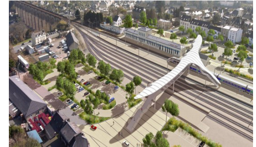
Pôle d'Echanges Multimodal (PEM) de la gare de Morlaix
