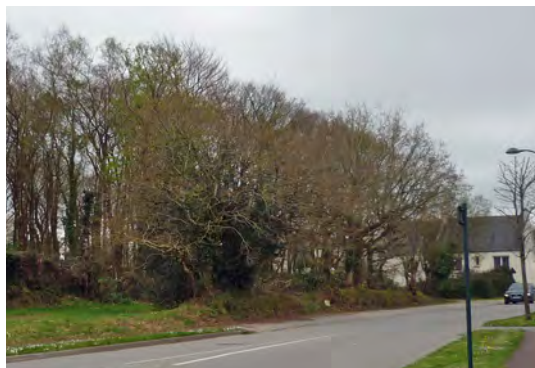
Talus et haie sur la voie de Keranna
