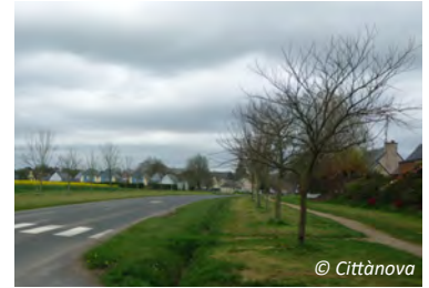
Vue sur l'aménagement de l'autre côté
