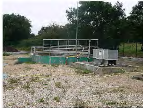
Décanteur digesteur – Station d'épuration
