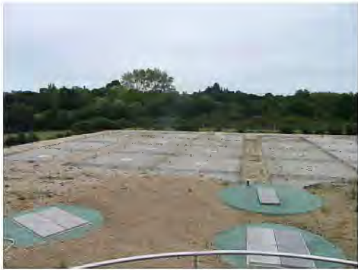
Filtres à sable
