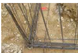
Nœud de chaînage - Continuité mécanique
