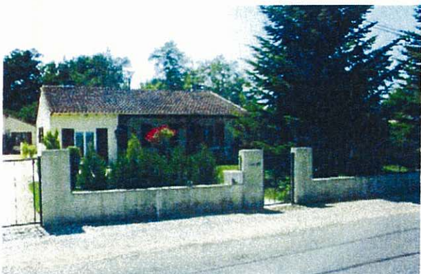
Pavillon le long de la RD 70 (1980)
