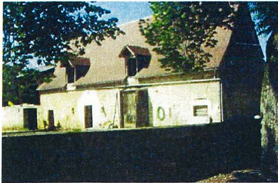
Bâti agricole rénové à l'Ouest de Surjac
