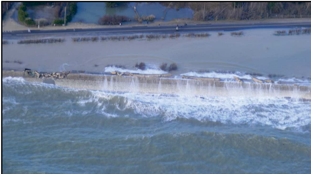
Submersion de la digue du Martray par rupture de la protection
