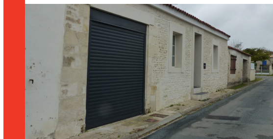
Porte dont le matériau et la couleur ne correspondent pas au bâti ancien
