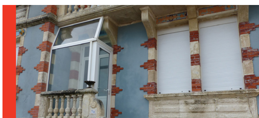
Perron fermé par un vitrage sur structure plastique
