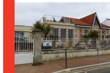
Extensions multiples et gabarit trop imposant par rapport au bâtiment d'origine
