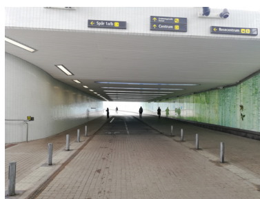
Tunnel à Umeå - Suède
