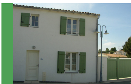
Maison au volume compact, implantée à l'alignement de la rue et prolongée par un mur haut
