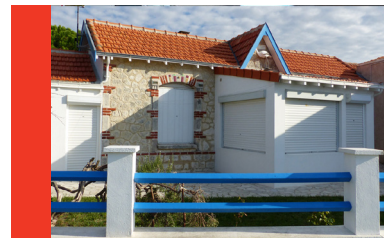
Extension sur l'avant de la maison et d'une architecture trop simpliste
