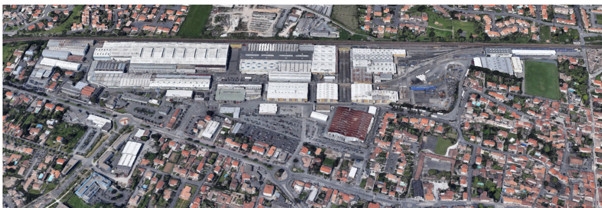
Vue aérienne du site (Source : Google Earth).
