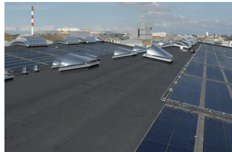
Exemple de pose de panneaux photovoltaïques en toiture - Communauté d'agglomération de La Rochelle - Source : Cegelec
