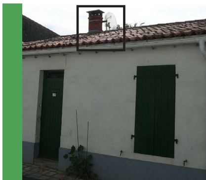
Parabole implantée en toiture, dissimulée par une cheminée
