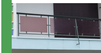
Garde-corps métal et verre dépoli
