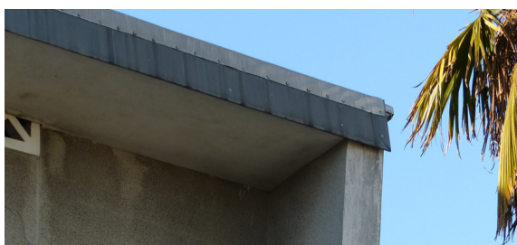
Un débord de toiture comme élément de protection de la façade
