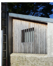
Construction contemporaine adossée à un mur ancien
