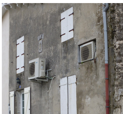
Pompes à chaleur encastrées et implantées sur une façade ancienne le long de la rue
