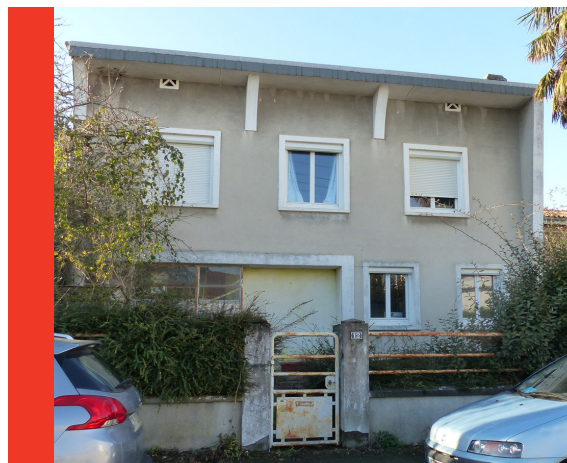
Les volets jaunes remplacés par des volets roulants blancs ont fait perdre les notes de couleurs de la façade
