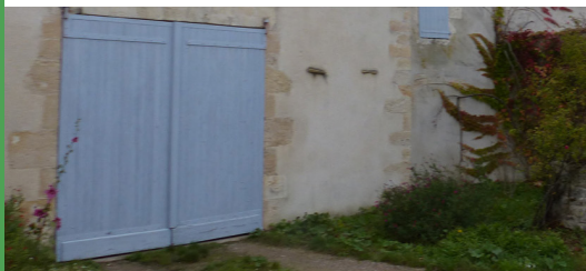
Porte de grange à lames de bois verticales peintes
