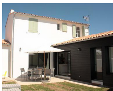
Maison de type traditionnel côté rue avec élément un peu plus contemporain à l'arrière (alliance enduit et bois peint)
