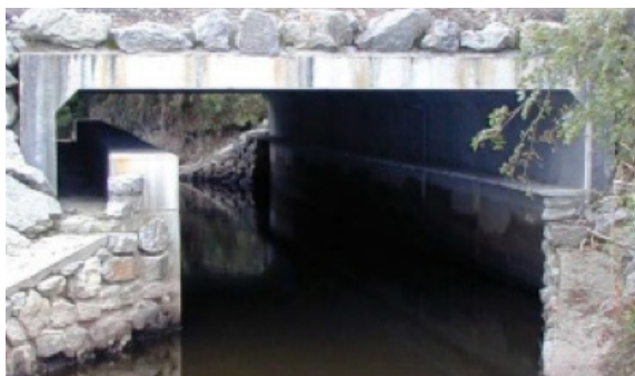
Exemple d'aménagement sous voirie favorable à la loutre (PNR Brière).
