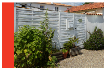
Mur remplacé par des panneaux de bois préfabriqués
