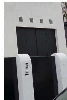
Pavés de verre en imposte d'une porte de garage
