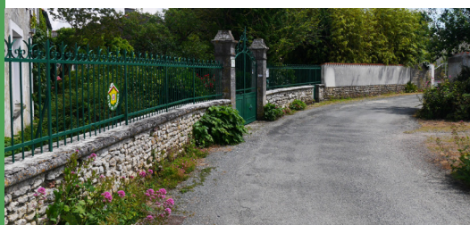
Mur bahut surmonté d'une grille et pieds de murs plantés
