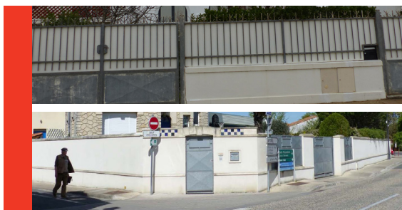
Clôture opacifiée et mur bahut surélevé
