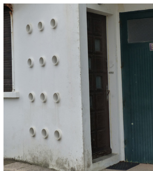
Moucharabiehs : voiles de béton perforés au niveau d'une porte d'entrée
