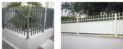
Grilles sur mur bahut, sans et avec festonnage
