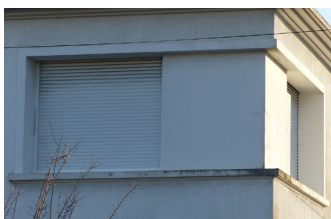
Fenêtres d'angle avec encadrement en relief et volets roulants en bois
