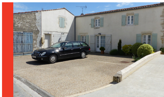
Clôture supprimée et jardin avant transformé en stationnement
