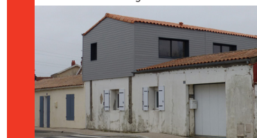
Surélévation dont les percements ne respectent pas l'ordonnancement de la façade d'origine (baies larges)
