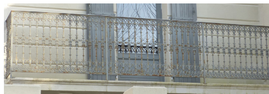
Exemple de garde-corps de balcon en ferronnerie
