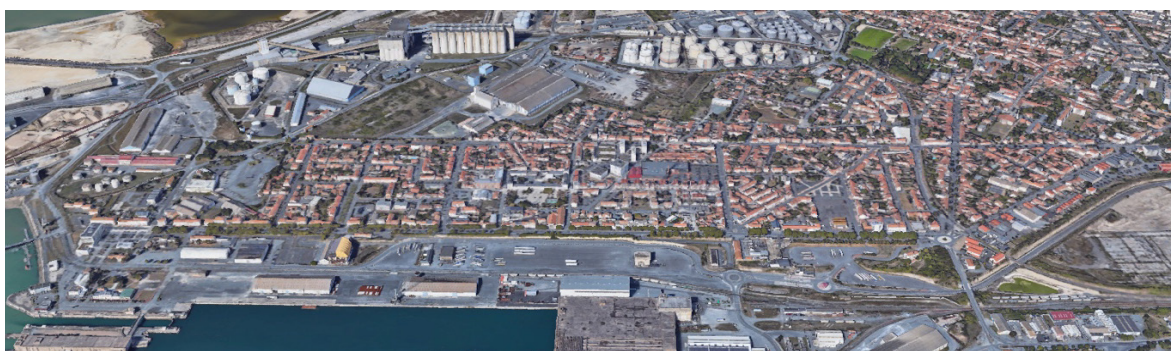
Vue aérienne du site (Source : Google Earth).
