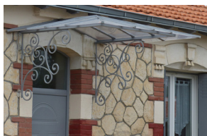
Exemples de marquises en ferronnerie
