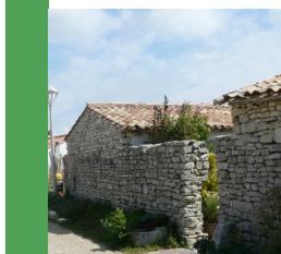
Construction en surélévation d'un mur ancien
