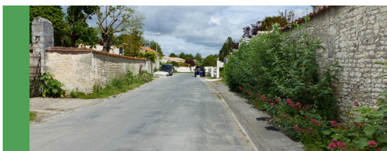
Murs en pierre entretenus et pieds de murs plantés
