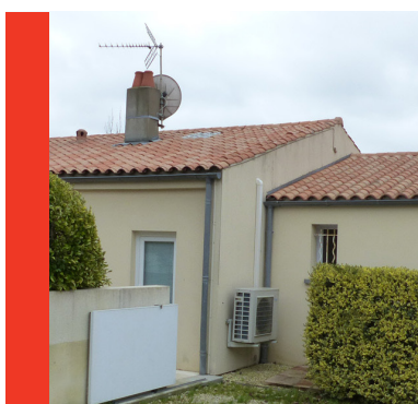
Parabole et pompe à chaleur visibles
