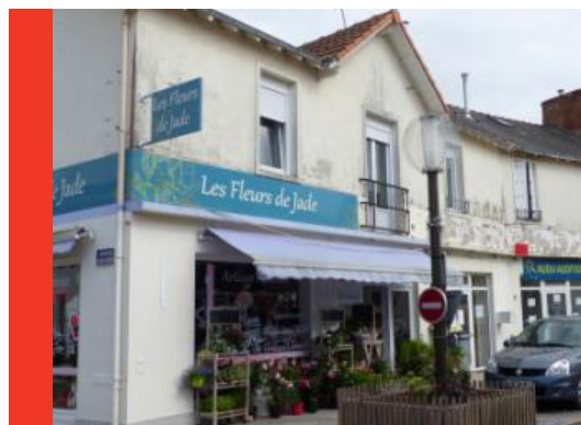
La même maison avec un événement du rez-de-chaussée et de nombreuses pertes de décor
