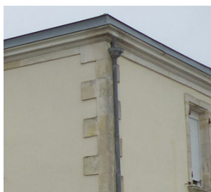
Chaînage harpé et enduit couvrant
