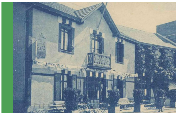
Une maison balnéaire avec ses baies d'origine et tous ses détails de décor
