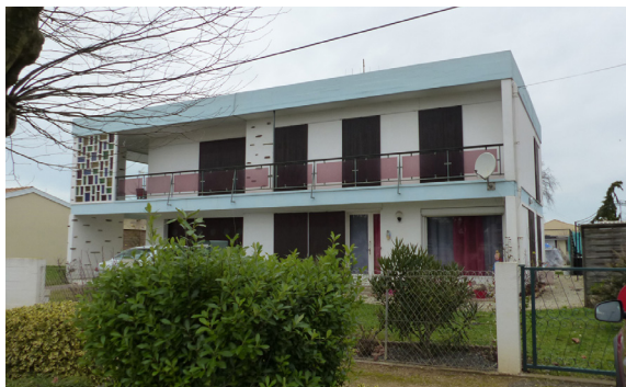
Toitures terrasse et monopente largement débordantes sur la façade principale
