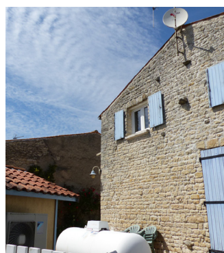
Multiplication d'éléments techniques visibles sur rue (parabole, pompe à chaleur, cuve)
