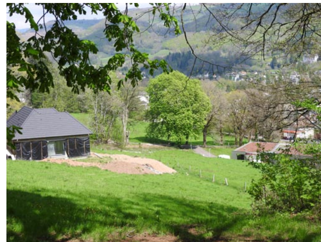
Constructions existantes sur le site (coups partis)
