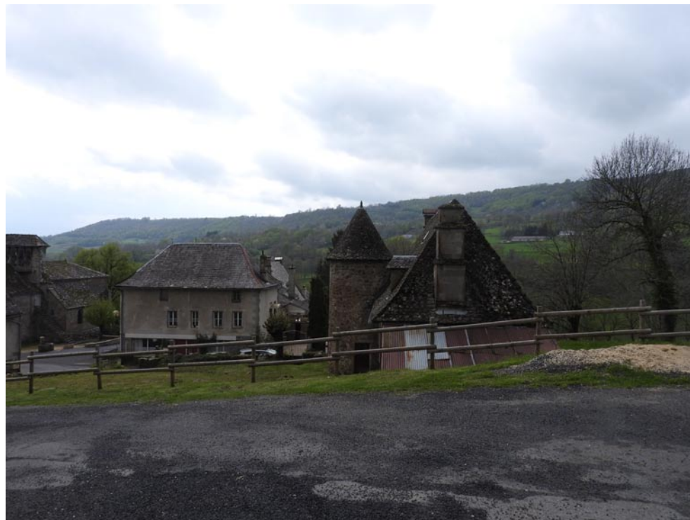
Point de vue sur le village depuis le site d'OAP
