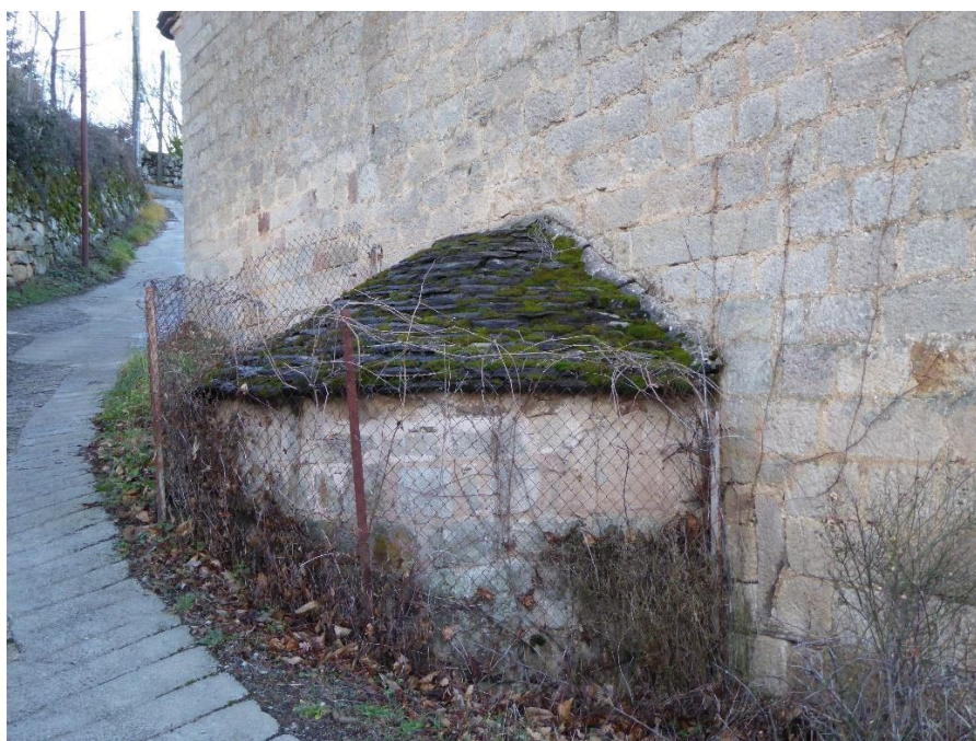
Four accolé à un bâtiment (Saint Beauzély)
