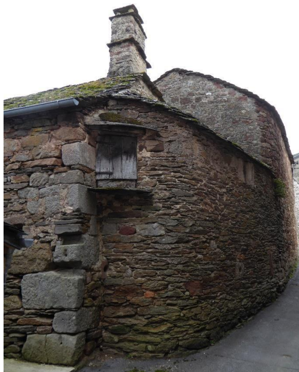
Bâtiment à Castelnau Pégayrols
