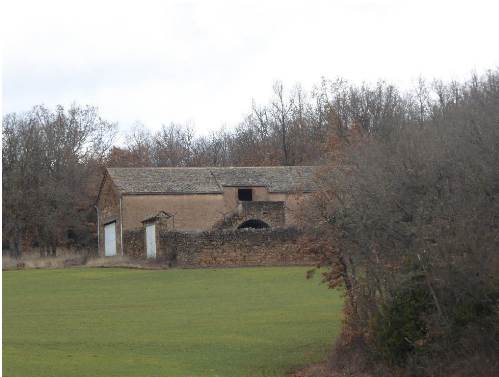
Bâtiment agricole aux Bouscaillous (Castelnau Pégayrols)
