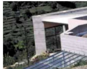
Maison en béton brut
