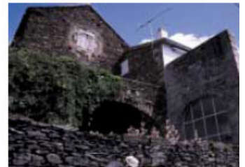
Extension d'un bâti ancien
