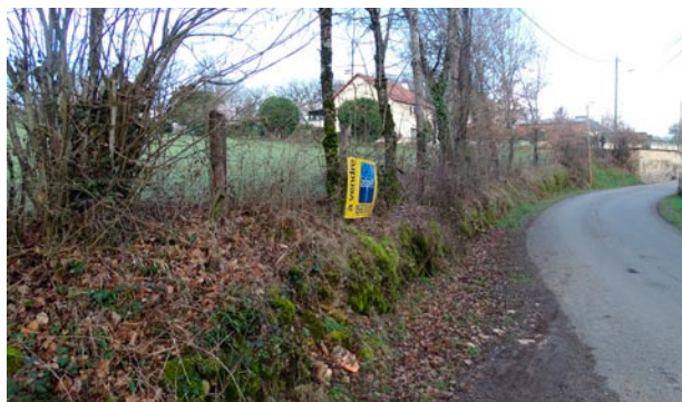
Talus identifié en limite Nord
