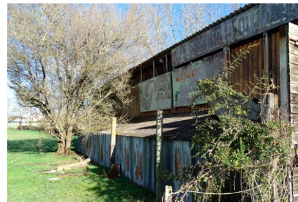
Bâtiment à démolir
