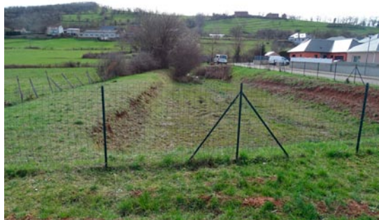
Zone de gestion de l'eau existante en limite Nord-Ouest du site
