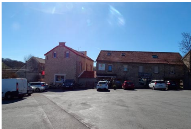
Secteur 2 - Stationnement existant
