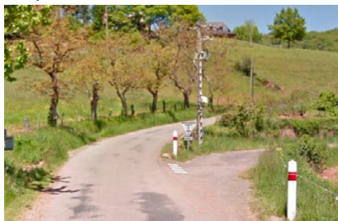
Intersection avec la RD228 à sécuriser
