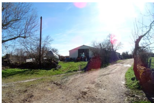
Bâtiment à démolir
