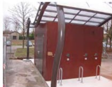
Abri à vélos électrique - CAPI (38)
