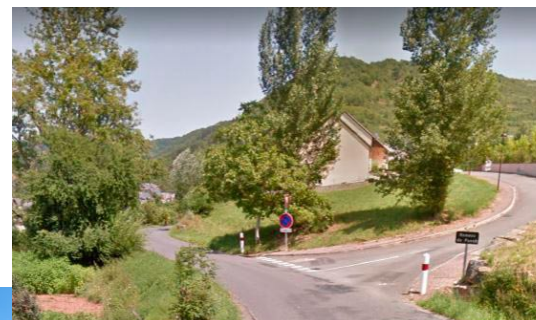
Carrefour avec la RD204 à sécuriser
