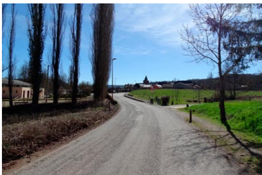
Entrée de bourg (RD57)
