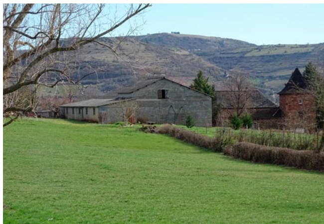
Bâtiment à requalifier
