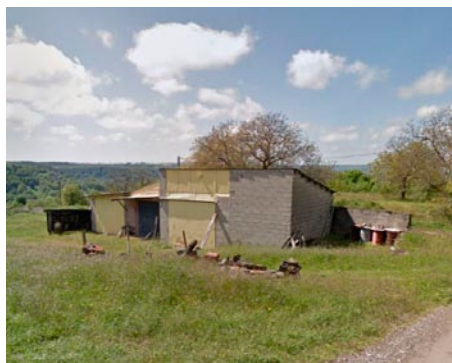
Bâtiment à démolir
