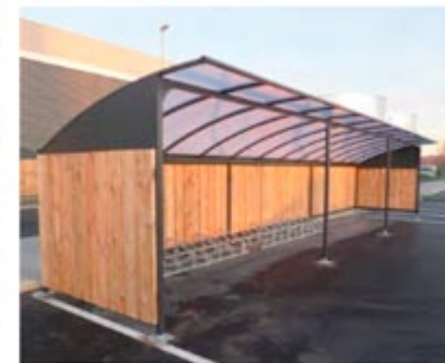
Abri-vélos pour entreprise à Sandouville (76)
