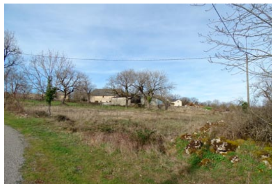
Vue sur le site et sur le bâtiment à démolir depuis la voie à l'Ouest
