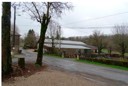
Vue sur le bâtiment à démolir depuis le Chemin de Pérignagols
