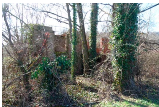
Bâtiment existant du secteur 2
