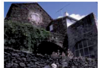
Extension d'un bâti ancien
