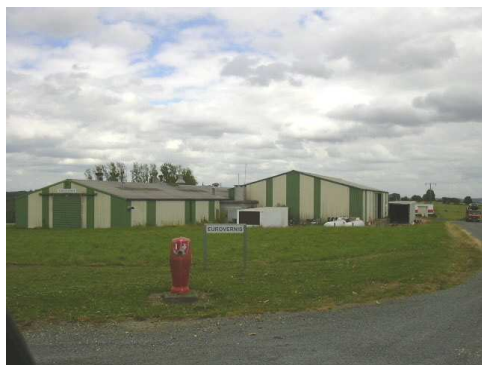
Hangars dans le bourg de Saint-Priest-les Fougères
