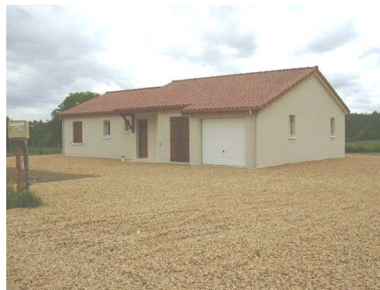
Exemple de construction nouvelle à Sainte-Marie-de-Frugie (La Coquille)
