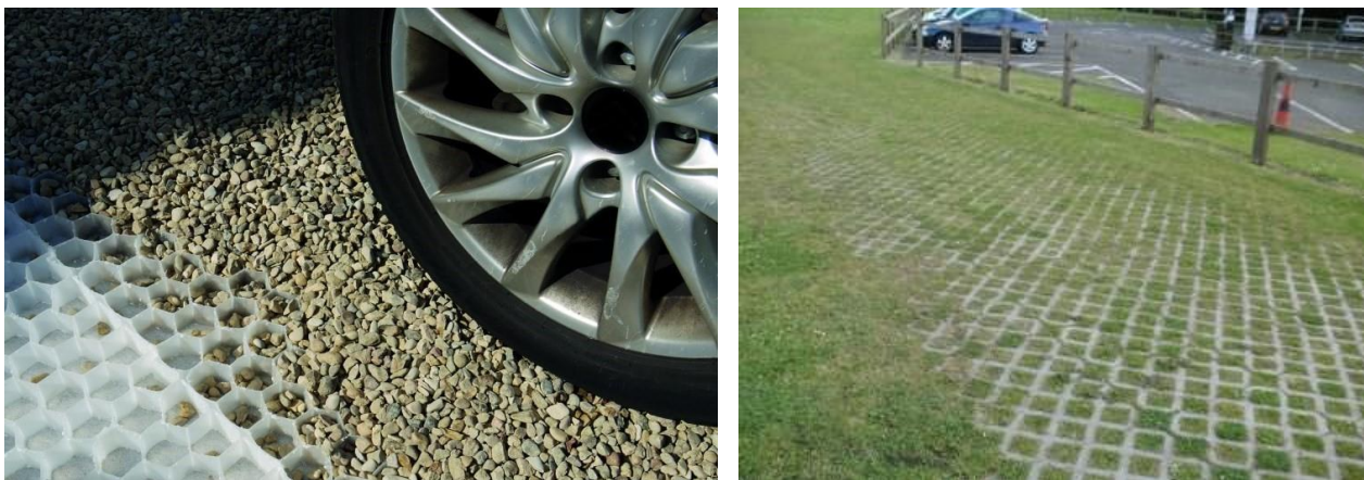
Exemples de revêtements perméables et carrossables
