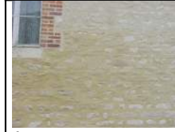
2 Enduit brossé sur pierres non taillées à fleur de parement.
