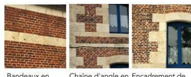
Bandeaux en briques en terre cuite et joints de mortier de chaux
