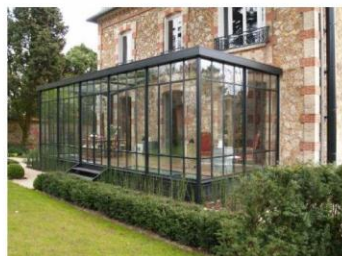
Soubassement en brique et division anarchique du vitrage
