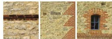
Bandeaux en briques en terre cuite et joints de mortier de chaux Chaîne d'angle en briques en terre cuite et joints de mortier de chaux Encadrement de baie en briques en terre cuite et joints de mortier de chaux
