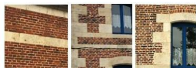
Bandeaux en briques en terre cuite et joints de mortier de chaux
