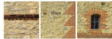
Bandeaux en briques en terre cuite et joints de mortier de chaux Chânes d'angle en briques en terre cuite et joints de mortier de chaux Encadrement de baie en briques en terre cuite et joints de mortier de chaux
