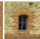
Encadrement de baie en briques en terre cuite et joints de mortier de chaux
