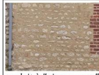
enduit à "pierres vues" ou à fleur de parement irrégulier.
