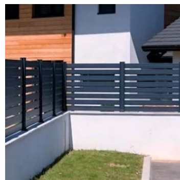
Mur surmonté d'un dispositif à claire-voie
