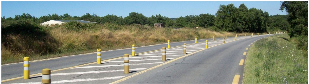
Vue depuis la RD 6089 en venant de PERIGUEUX
