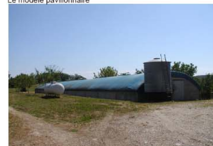
Insertion des bâtiments agricoles contemporains
