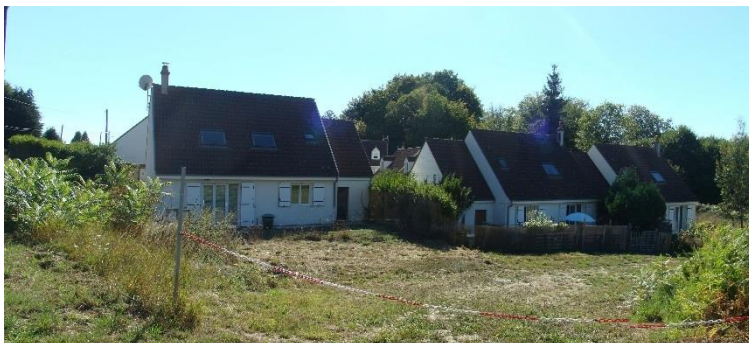
Vue sur les logements sociaux France Loire
