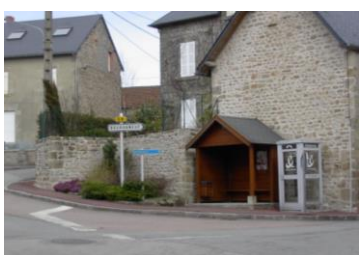
Photo 24 Aménagement paysager (D7/D8)
