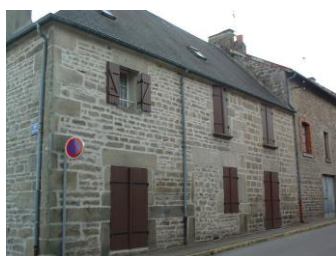
Photo 18 Maison de bourg rénovée
