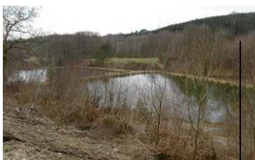
Photo 11 Lagunage pour le bourg de Royère-de-Vassivière
