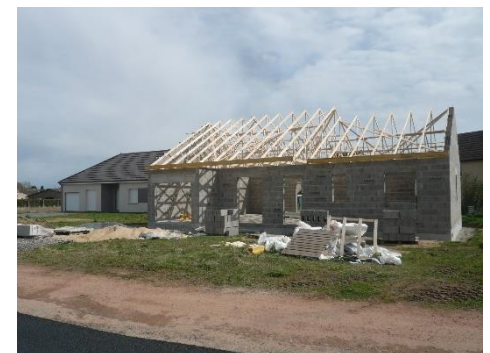
Bâti dans le lotissement existant. Dernière construction en cours
