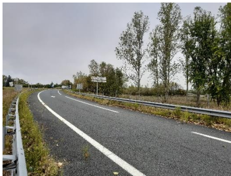
Bretelle de sortie nord de la N145 avant le rond-point et avant la façade de la future zone d'activité
