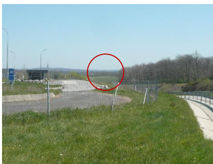
Ouest - Arrivée à l'aire de service : vue de la partie nord du site
