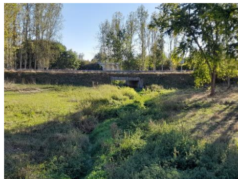
La Goze à travers l'échangeur. La bretelle de sortie est en talus et au-dessus de la Goze (pont). Le terrain est en creux et en partie inondable, côté gauche de la photo.
