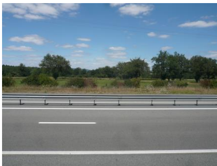
Rive Nord à hauteur de la bretelle d'accès à la N145 : vue la plus large sur le site
