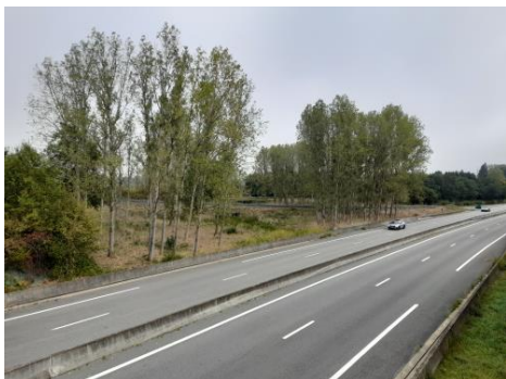
La Goze passe à travers l'échangeur, ici entre la N145 et la bretelle de sortie nord (arrière-plan) en contrebas du terrain de projet.
