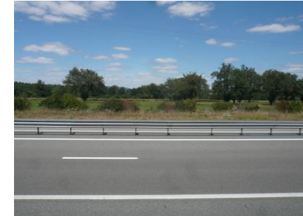
Le terrain est plat, en léger contrebas de la N145, et en partie à découvert.
