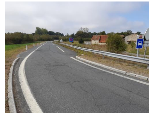
Bretelle d'entrée nord de l'échangeur n°43 en direction de Guéret
