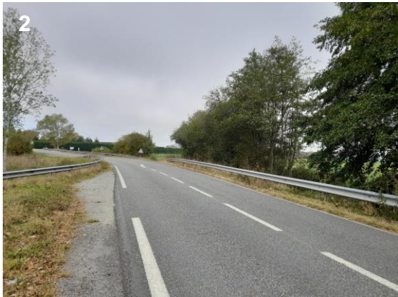
D7 longeant la zone AUs avant le rond-point. La bretelle de sortie nord de la N145 ne longe pas la zone AUs.
