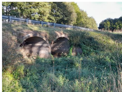
La Goze est busée pour permettre le passage de l'eau sous la D7. La Goze passe sous la bretelle de sortie par un pont.
