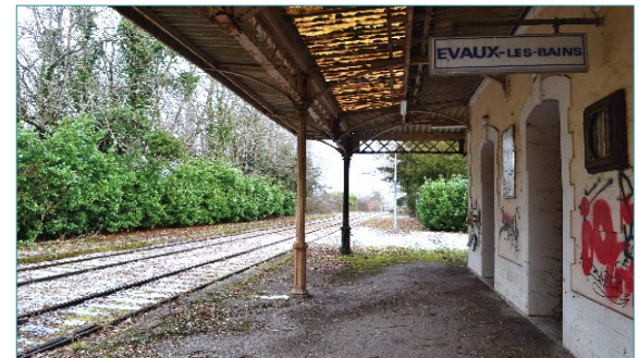
Gare d'Evaux-les-Bains © Arthur Lorcerie
