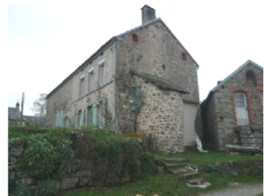
Pierrefitte. Four à pain familial sous un toit, accolé au pignon de la maison
