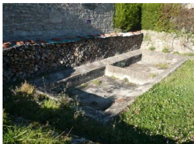
Busseau-sur-Creuse. Lavoir d'un complexe hydrique comprenant également un puits circulaire bouché et une source aménagée couverte par un édifice en granit
