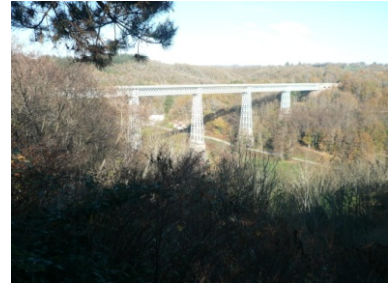
6. Viaduc de Busseau 19 ème siècle
