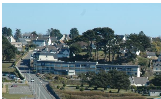
Logements collectifs ou accolés à Trestel
