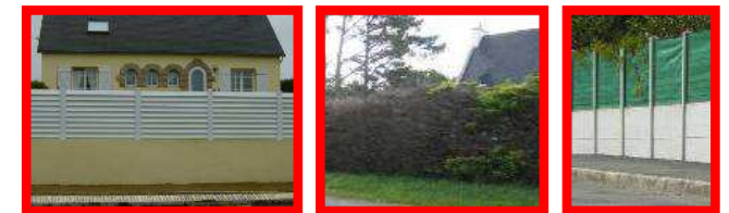
Exemples de dispositifs à éviter
