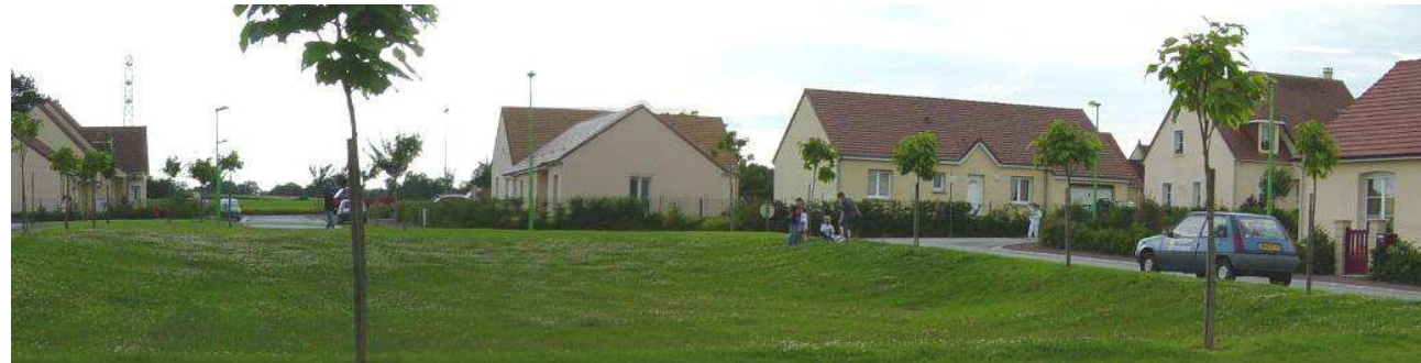
Bassin de rétention faible profondeur
