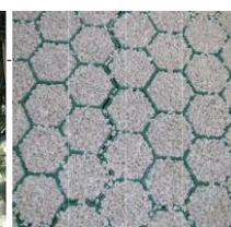
Exemple de matériaux perméables : dalle béton enherbée, gravillons, pavés non jointoyés
