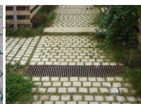
Exemple de matériaux perméables : dalle béton enherbée, gravillons, pavés non jointoyés
