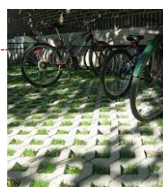
Exemple de matériaux perméables : dalle béton enherbée, gravillons, pavés non jointoyés
