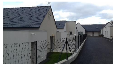
Opération récente de logements groupés, rue du Phare de la Corne
