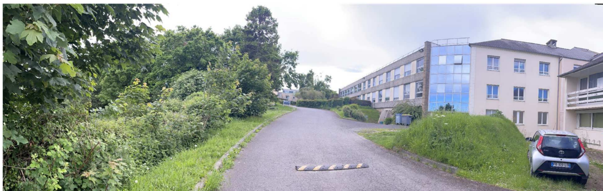
Vues vers le site depuis l'hôpital
