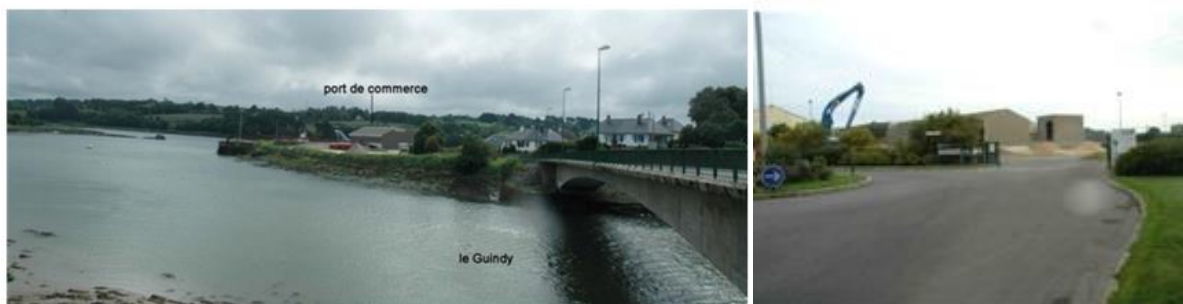
Vues de l'éperon du port de commerce depuis le Pont Noir et depuis le rond-point de la RD70
