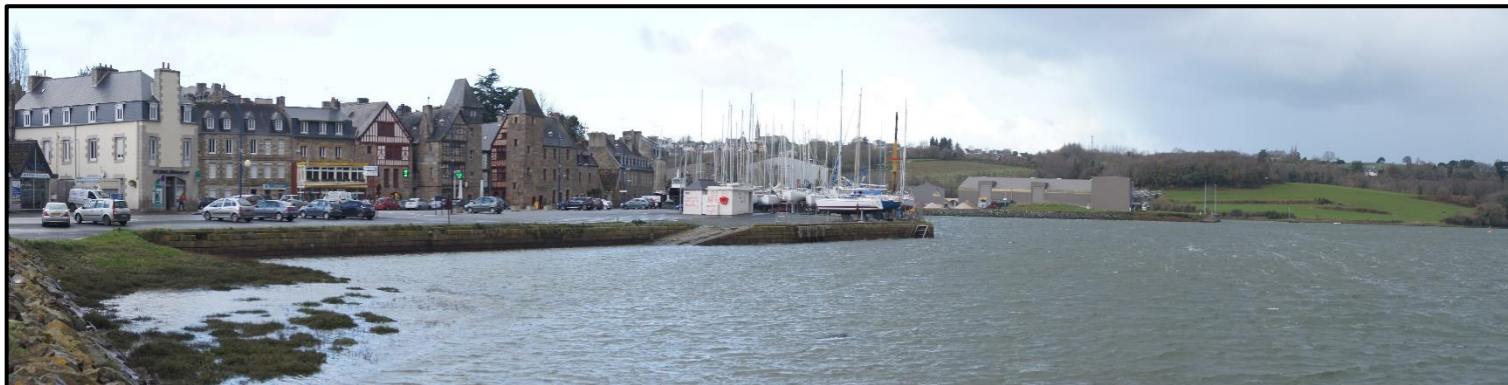
Port de commerce et parking sur les berges du Jaudy
