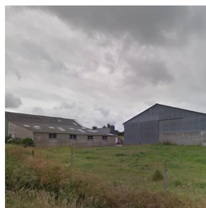
Les hangars agricoles du bourg
