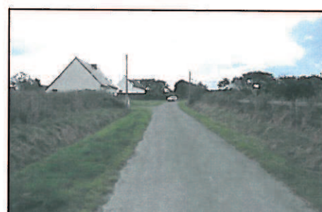
Connecté à la RD 88, le chemin de Kergervenn permettra de distribuer les futures constructions. La requalification de la route départementale n°88 représente également un enjeu majeur dans la structuration de l'agglomération.
