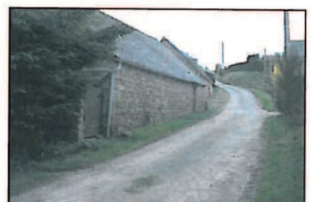
Le tissu urbain de Kerbabu associe ancien hameau agricole de caractère et lotissement pavillonnaire.
