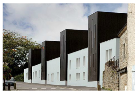
Habitat collectif Saint Nolf, ARCAU architecte
