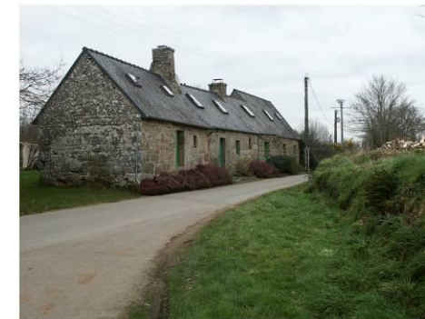
Bâti ancien du hameau de Kerjean.
