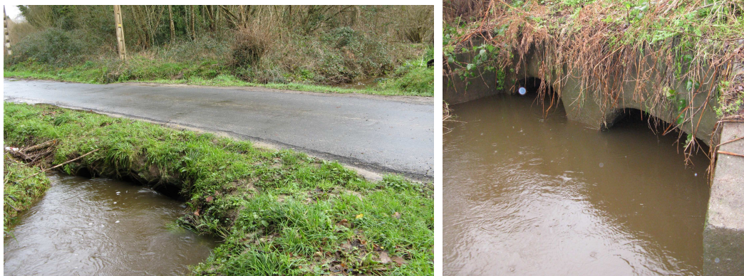
Figure 13 : Canalisation du Cruguil sous la rue de la Chapelle puis sous la RD788 (photographies prises en janvier 2014)
