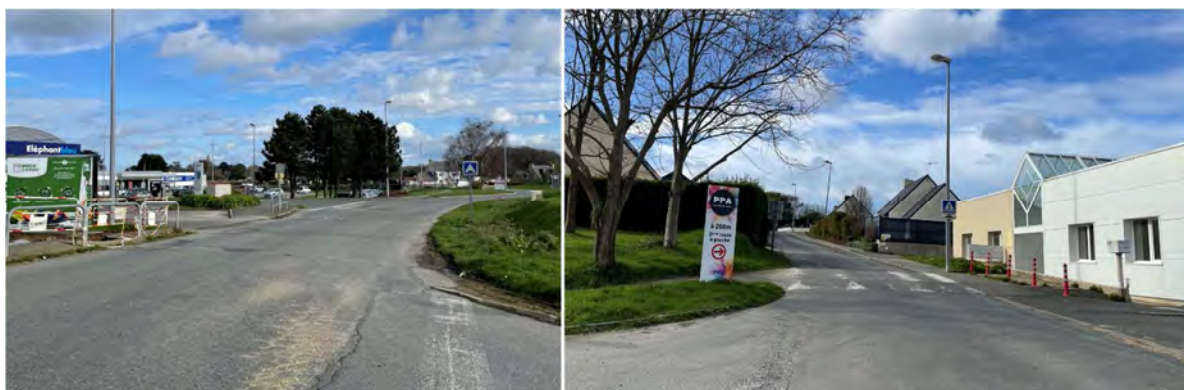
Tronçon sud de la rue de Kerliviec
