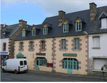
Maisons et magasins de commerce (limite 19ème / 20ème siècle), rue de la Côte des Bruyères
