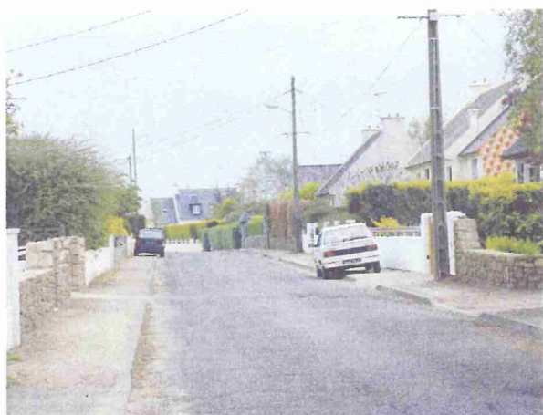
L'effacement des réseaux est à poursuivre en centre bourg.
